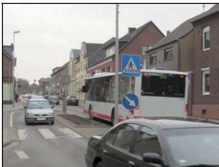
Gefahrenstelle: Hier ist es viel zu eng!
